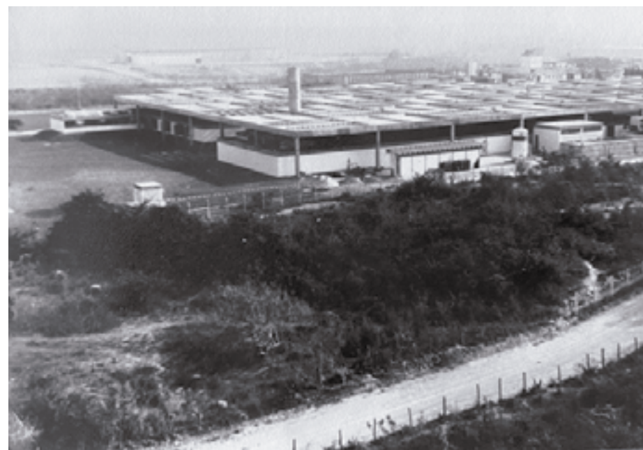
Fig. – 440 – Vista parcial das instalações da empresa “Transit” localizada em Montes Claros, MG no começo de 1974.
