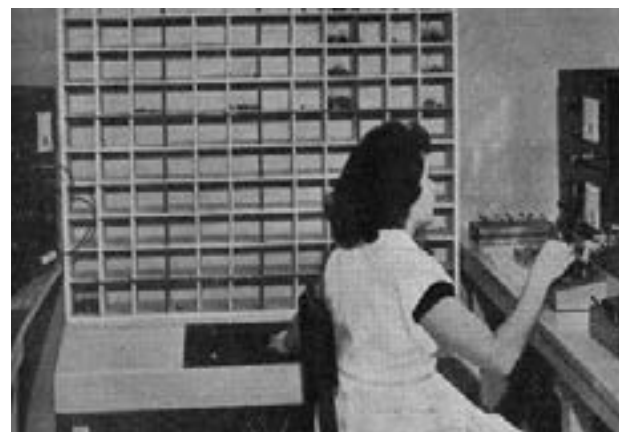
Fig. 386 – O processo de classificação e seleção elétrica do transistor após sua fabricação. Quatro parâmetros são medidos e os seus respectivos valores transmitidos para quatro comutadores, que automaticamente aciona um indicador luminoso no escaninho correspondente ao tipo do transistor em teste.
